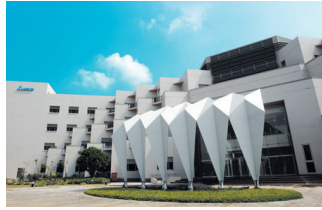
Tainan Fabrika (Elmas Sınıfı Yeşil Bina)
